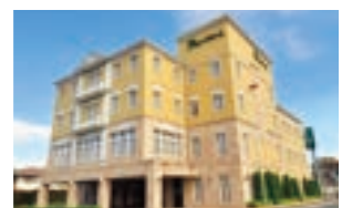
川越メモリードホール 川越市広栄町11-5 049-241-0983
