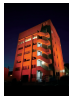
中広本社ビル
