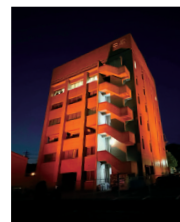
中広本社ビル
